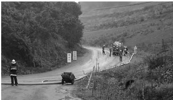
ポンプ車数台を継いで1100mを送水した
